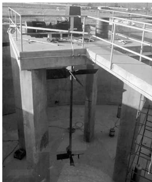
Рис. 1. Вертикальные лопастные мешалки
