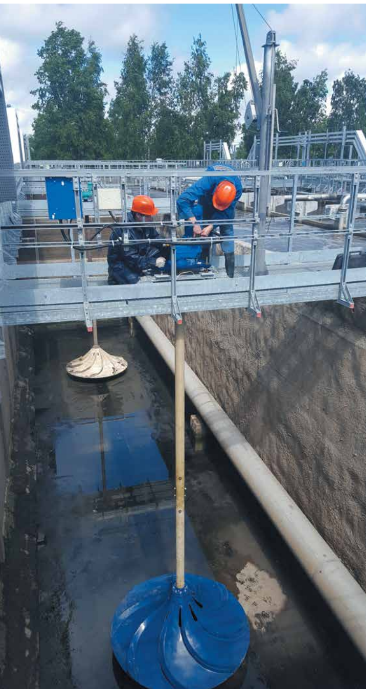
Рис.2. Монтаж мешалки GMS, 2017 г.
