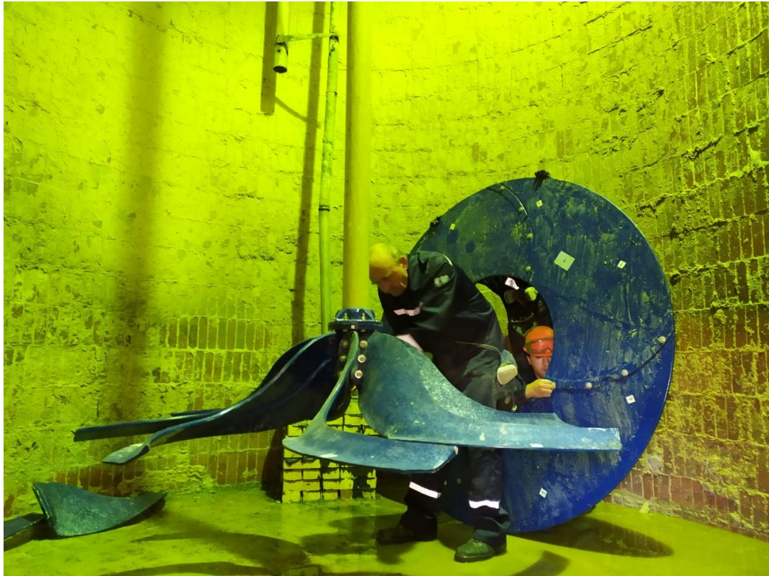
Рис.11. Монтаж мешалки в аппарате объемом 140 м 3
